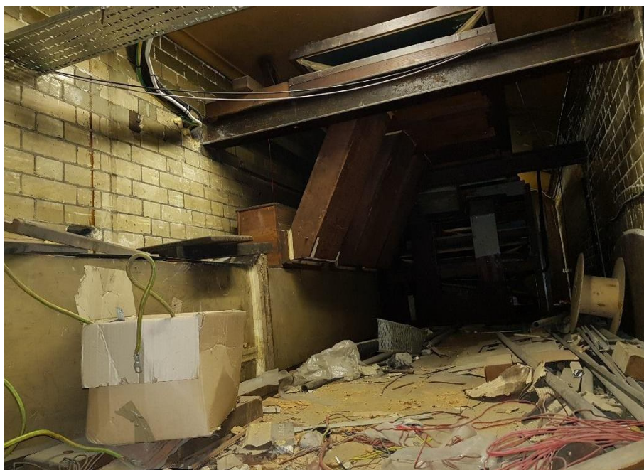
Inside the chambre de la soufflerie prior to dismantling
